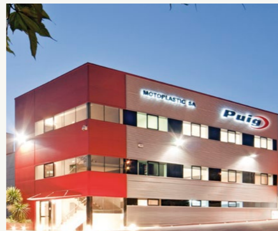
Remodelación de la sede central de Puig en Granollers.
